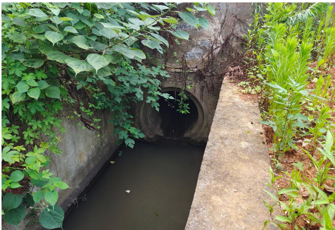
图 3 水库输水管出口现状
