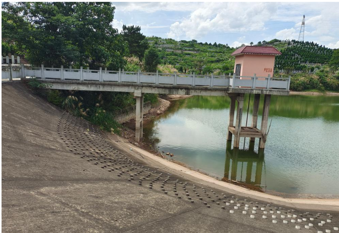
图 2 水库迎水面坝坡现状
