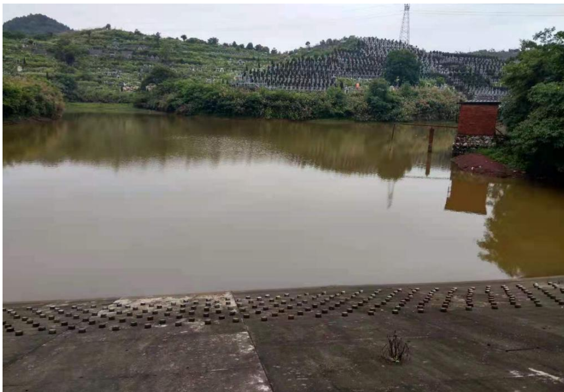
图 4 水库迎水面坝坡现状，水库岸线现状大部分为墓地
