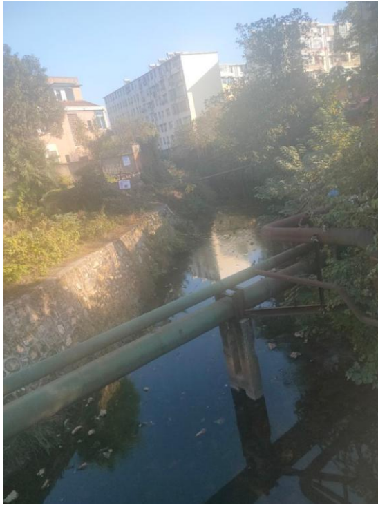
图 3 港道现状（已治理港段）
